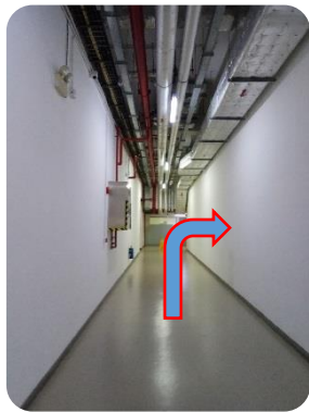
機場物流商務中心走廊
