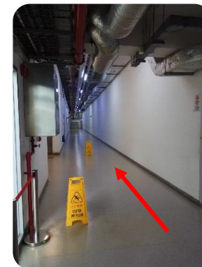
機場物流商務中心走廊
