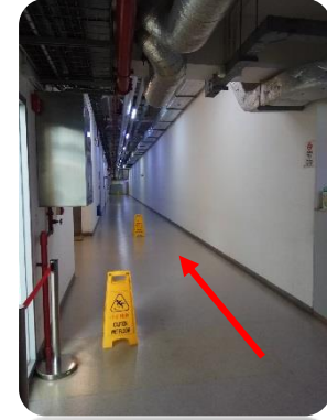
機場物流商務中心走廊
