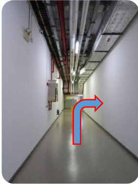
機場物流商務中心走廊
